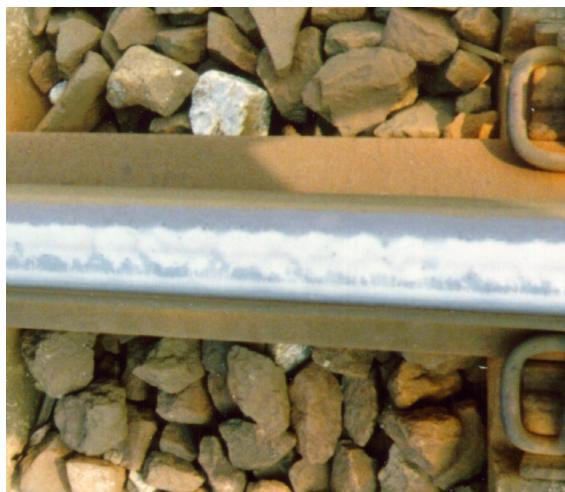
Bild 4: Veriffelte Schienenfahrrfläche
