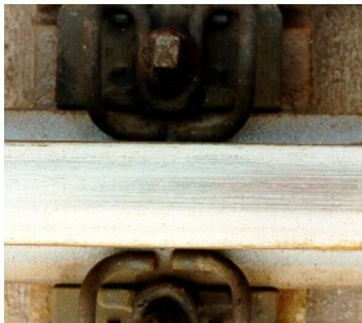
Bild 6: Oszillierend geschliffene Schienenfahrfläche
