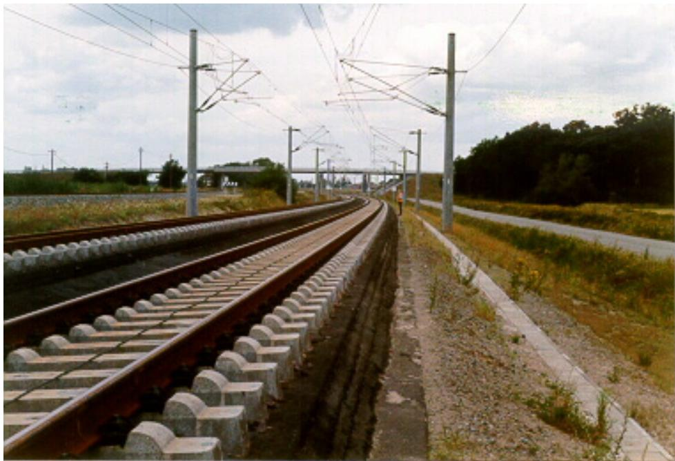
Bild 35: Feste Fahrbahn mit Asphalttragschicht (ATS)
