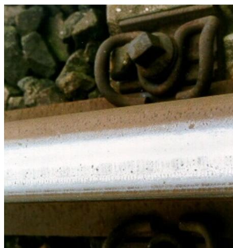
Bild 17: Schienenfahrfläche im durchschnittlichen Zustand
