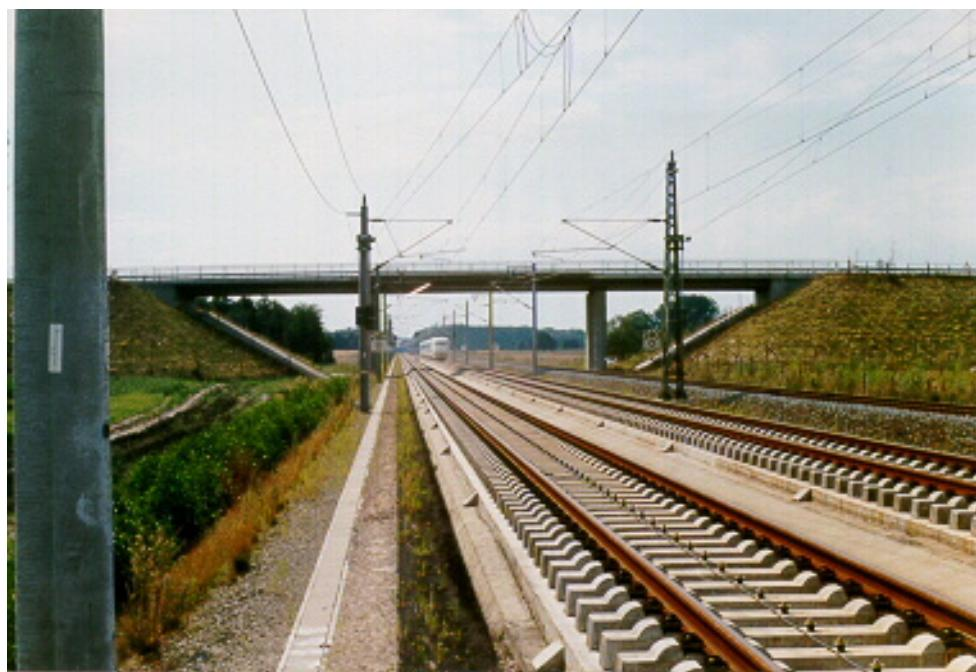
Bild 34: Feste Fahrbahn mit Betontragschicht (BTS)
