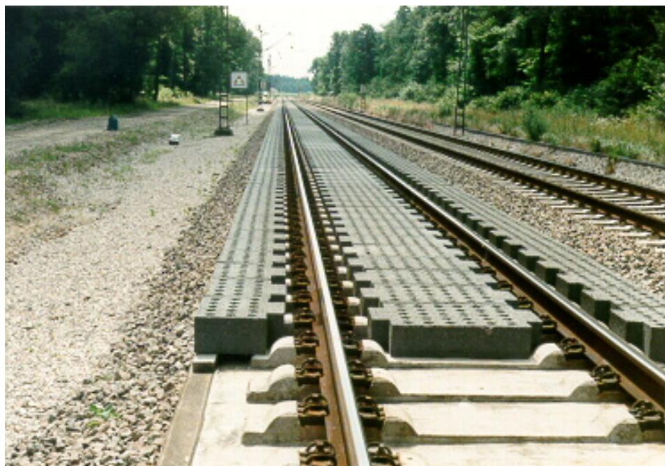
Bild 36: Feste Fahrbahn, monolithisch, mit Absorbern
