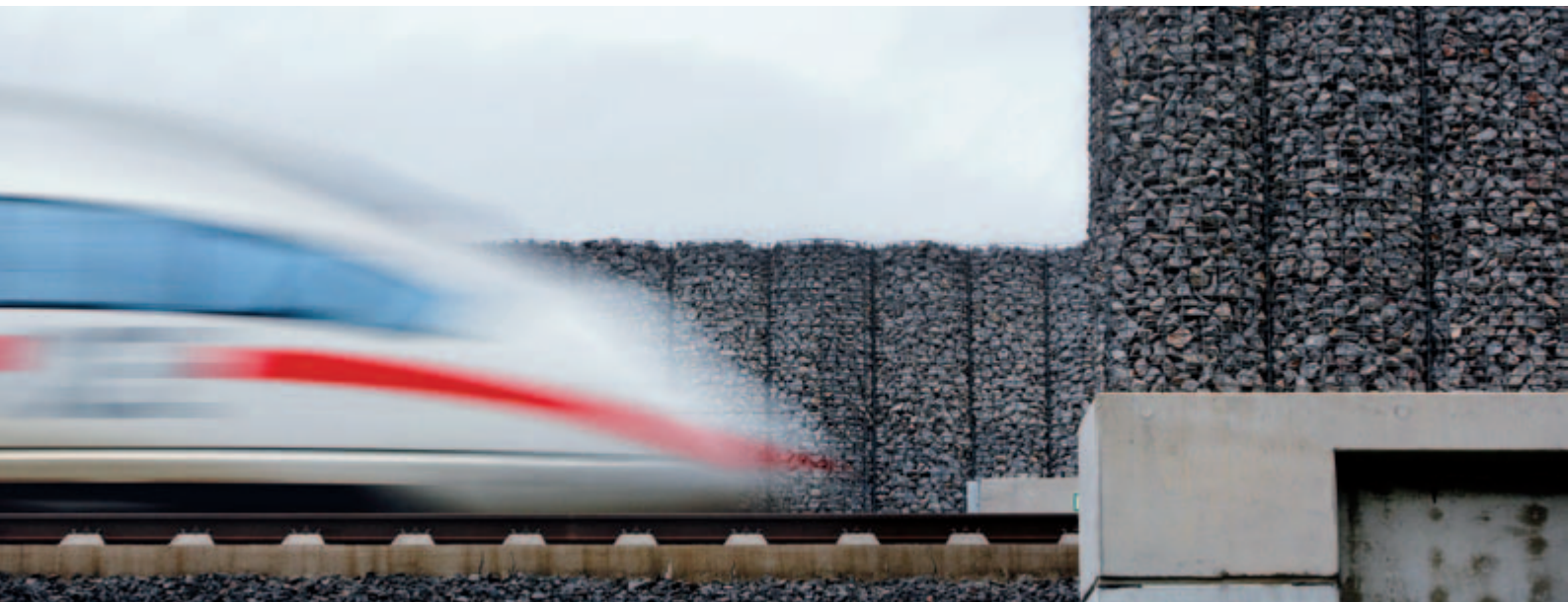
Beispiel einer Schallschutzwand aus Drahtgabionen, die mit Steinen befüllt wurden
