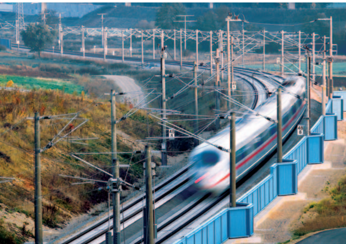
Fast 14 Kilometer Schallschutzwände wurden entlang der Neubaustrecke Nürnberg–Ingolstadt gebaut; hier: Schallschutzwände im Altmühltal bei Großhöbding
