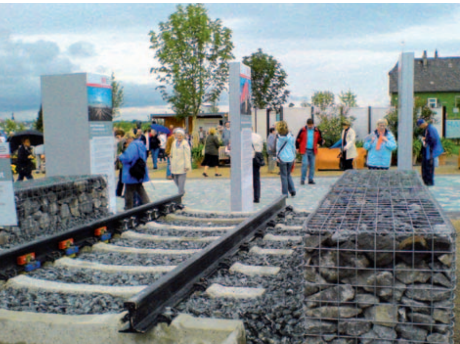
Niedrige Schallschutzwände aus Gabionen sowie Schienenstegbedämpfer im Modell auf der Landesgartenschau 2008 in Bingen
