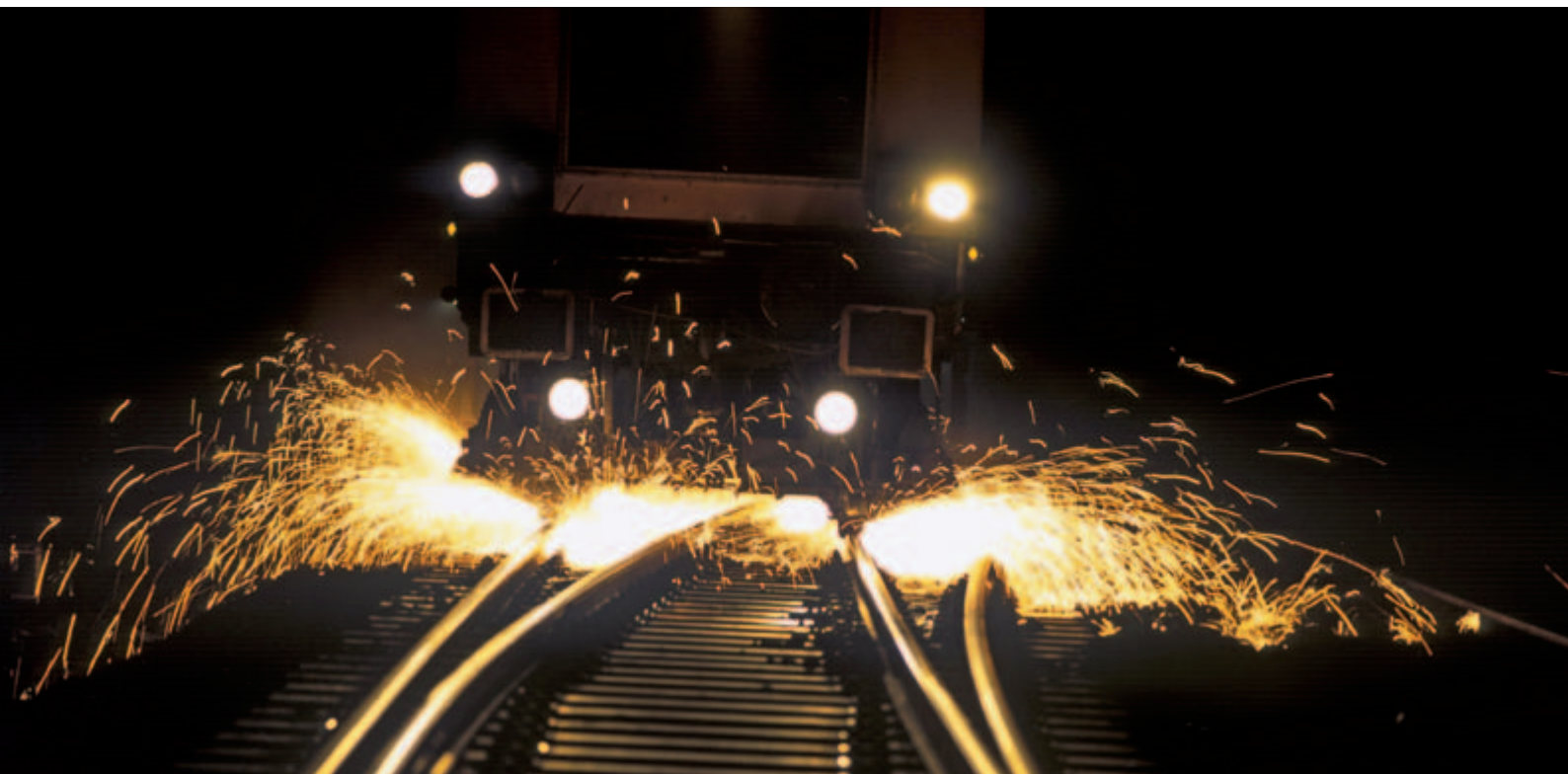
Besonders überwachtes Gleis: der Schienenschleifzug im Einsatz
